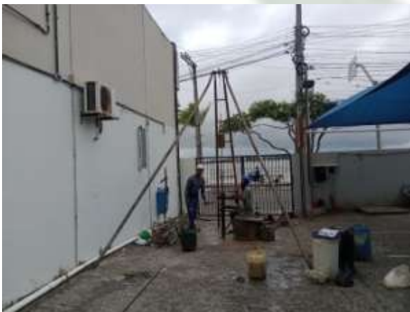
Foto 17 EXECUÇÃO DE SONDAGEM À PERCUSSÃO (SPT).
