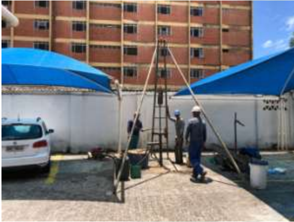
Foto 01 MOBILIZAÇÃO DE EQUIPAMENTO.
