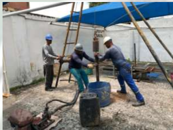
Foto 08 EXECUÇÃO DE SONDAGEM À PERCUSSÃO (SPT).
