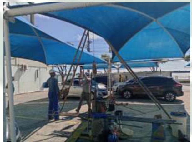
Foto 18 EXECUÇÃO DE SONDAGEM À PERCUSSÃO (SPT).
