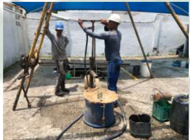
Foto 06 EXECUÇÃO DE SONDAGEM À PERCUSSÃO (SPT).
