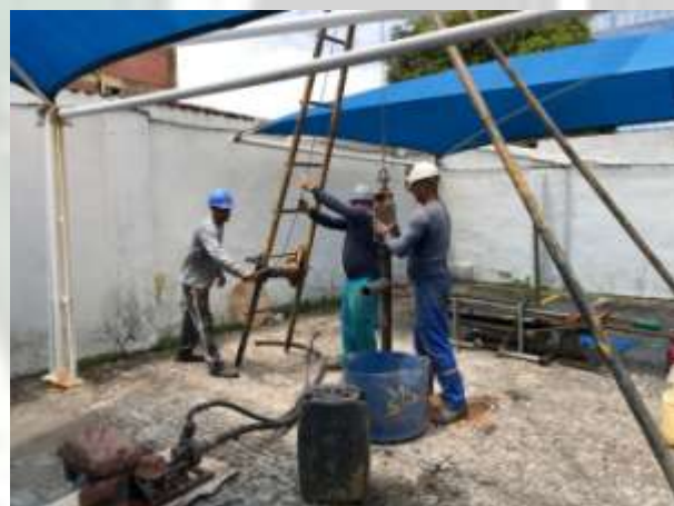
Foto 10 EXECUÇÃO DE SONDAGEM À PERCUSSÃO (SPT).
