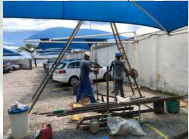
Foto 04 EXECUÇÃO DE SONDAGEM À PERCUSSÃO (SPT).
