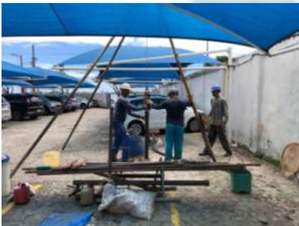
Foto 05 EXECUÇÃO DE SONDAGEM À PERCUSSÃO (SPT).
