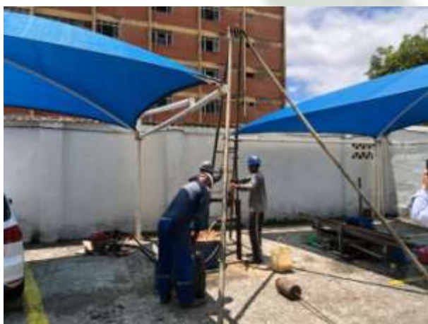
Foto 11 EXECUÇÃO DE SONDAGEM À PERCUSSÃO (SPT).
