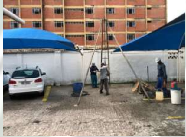
Foto 02 EXECUÇÃO DE SONDAGEM À PERCUSSÃO (SPT).
