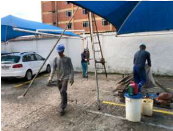
Foto 03 EXECUÇÃO DE SONDAGEM À PERCUSSÃO (SPT).
