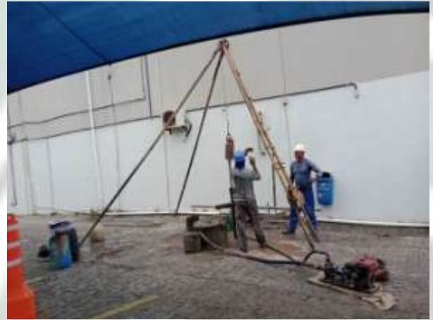
Foto 14 EXECUÇÃO DE SONDAGEM À PERCUSSÃO (SPT).
