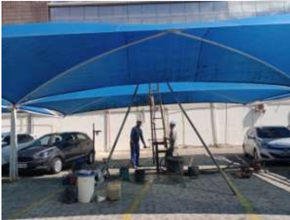
Foto 13 EXECUÇÃO DE SONDAGEM À PERCUSSÃO (SPT).
