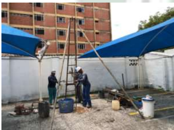
Foto 09 EXECUÇÃO DE SONDAGEM À PERCUSSÃO (SPT).
