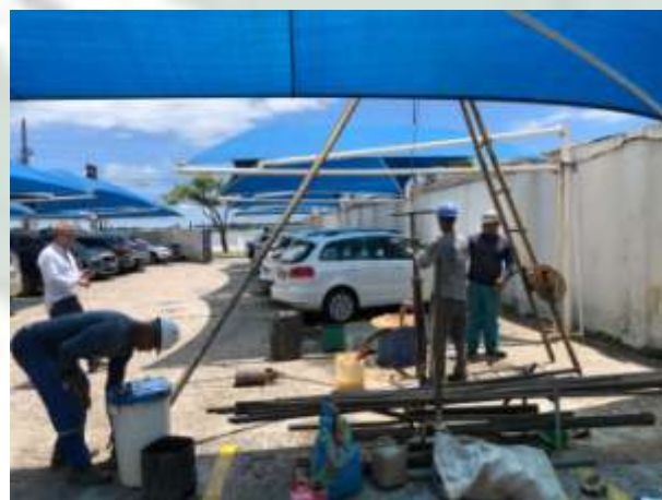
Foto 12 EXECUÇÃO DE SONDAGEM À PERCUSSÃO (SPT).
