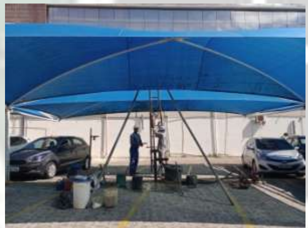
Foto 16 EXECUÇÃO DE SONDAGEM À PERCUSSÃO (SPT).
