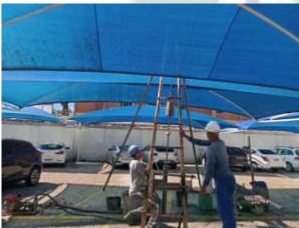
Foto 15 EXECUÇÃO DE SONDAGEM À PERCUSSÃO (SPT).
