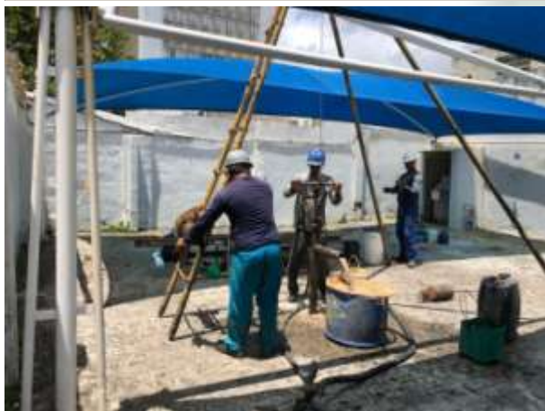
Foto 07 EXECUÇÃO DE SONDAGEM À PERCUSSÃO (SPT).
